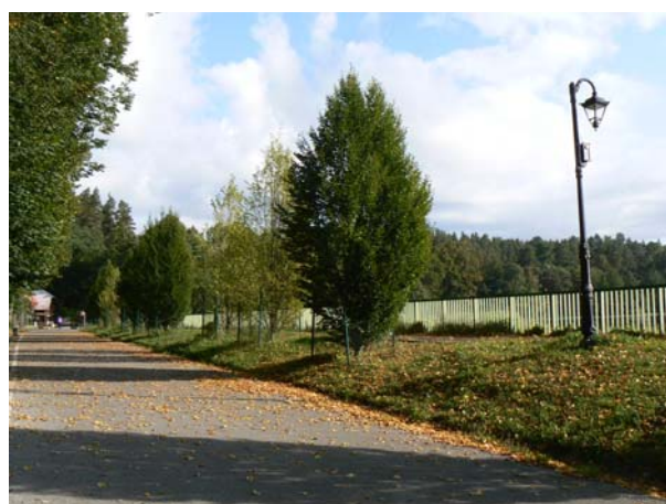
Pohled na korunu hráze a silniční komunikaci vedoucí po hrázi
