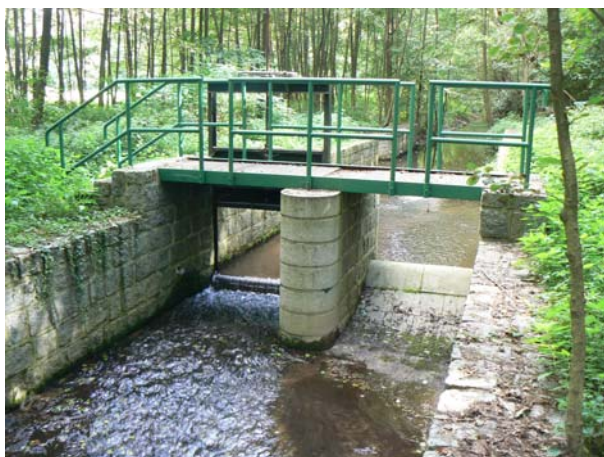
Rozdělovací objekt Chrastná (Osečná) – kombinovaný jez na Ploučnici (pohled proti vodě)
