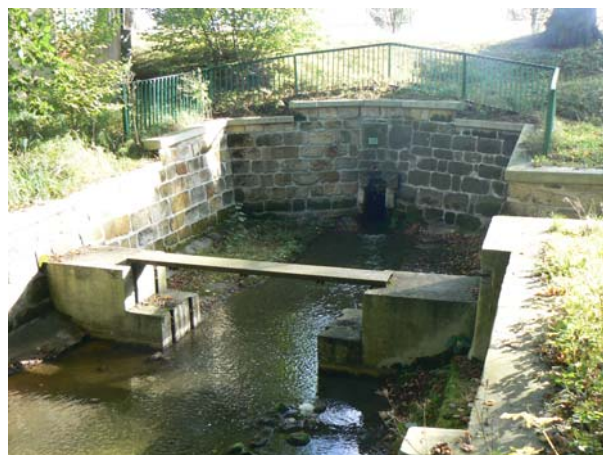
Výtok spodní výpusti do kádiště pod tělesem hráze
