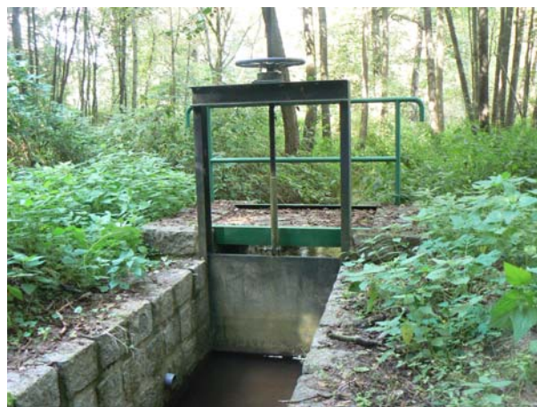
Rozdělovací objekt Chrastná (Osečná) – stavidlový jez na Hamerské strouze (pohled po vodě)
