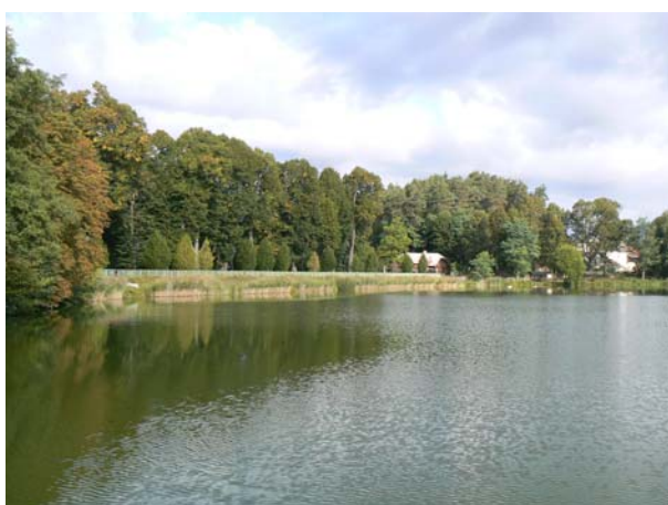
Pohled na návodní svah hráze Hamerského rybníka od bezpečnostního přelivu
