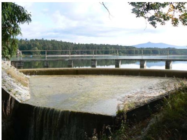
Celkový pohled na bezpečnostní přeliv
